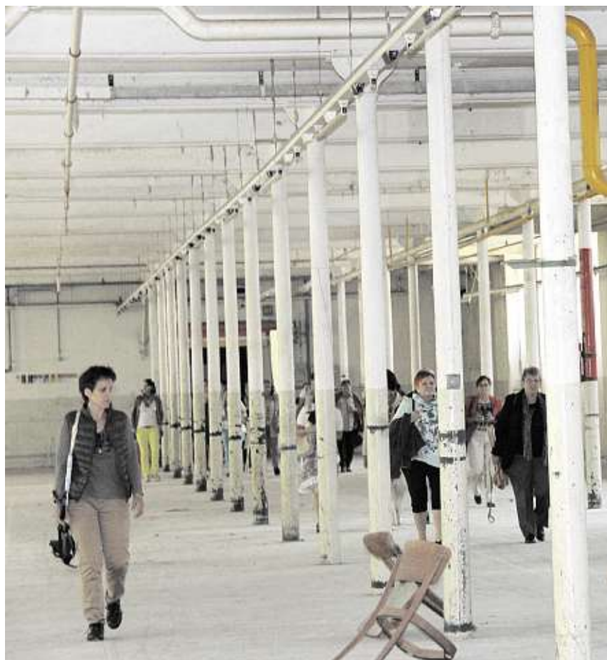
Wie in einer Kathedrale: Leere, gusseiserne Säulenhalle.
